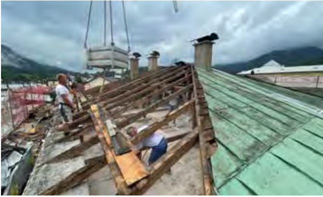
Instandsetzungsarbeiten am Dachstuhl
