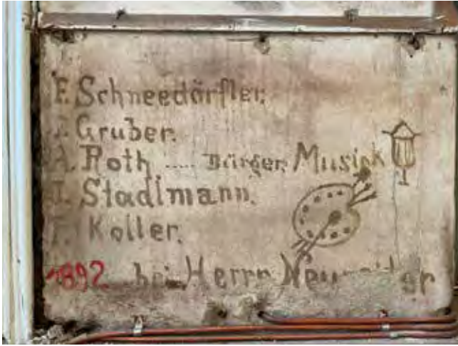
Versteckte Spuren früherer Renovierungen (Foto: Bundesdenkmalamt, jcr content)
